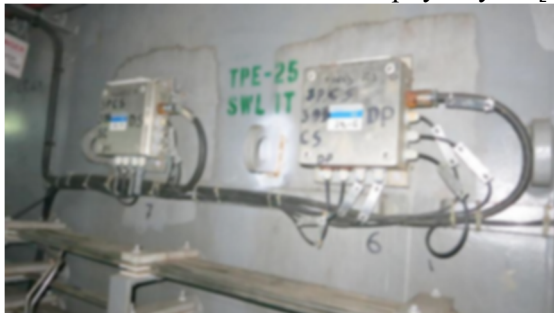
Рис. 8 Датчики динамічних навантажень системи OSTOPUS
